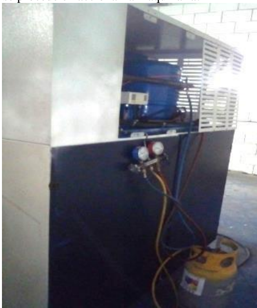
Fig. 6 Proceso de vacío del circuito y carga de gas.
