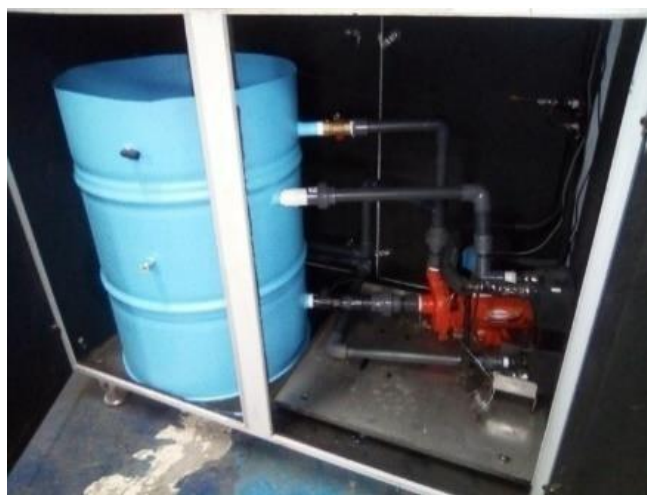
Fig. 8 Instalación del depósito de agua.
