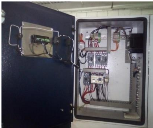
Fig. 5 Instalación de transformador y focos indicadores.
