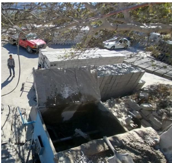
Fábrica 1(Lote A)
