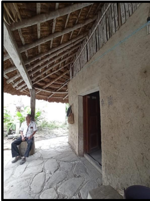
Figura 9 Vista Exterior de la Vivienda
